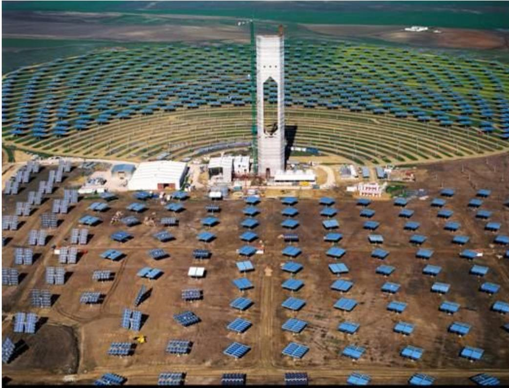
Figura 2. Planta solar de potencia eléctrica, al campo al frente es de 1MWe de paneles fotovoltaicos, el campo atrás es de 10 MWe térmicos de Torre Central. San Lucas la Mayor en Sevilla, España.
